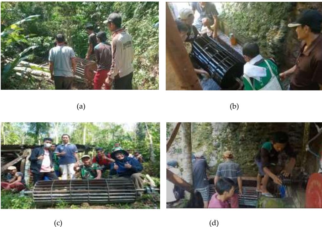
**Gambar 4. Proses penerapan turbin mikrohidro, a) Pendistribusian, b) Pembongkaran, c) Persiapan, dan d) Pemasangan**
